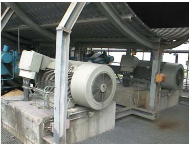
Hình 7 .Lắp biến tần cho các động cơ
