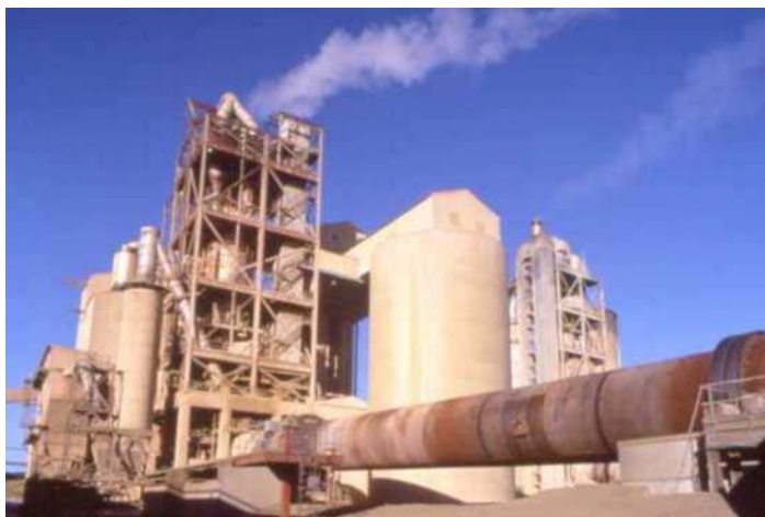
Hình 6. Lò xi măng với tháp sấy sơ bộ (Preheater)
